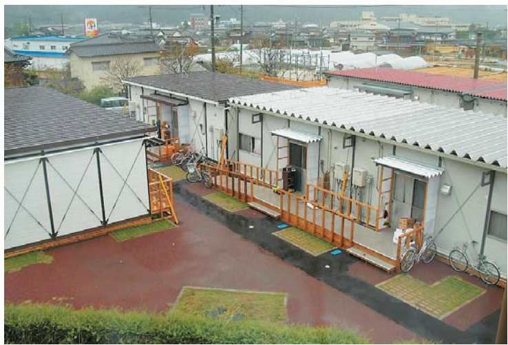
八女市黒木町の応急仮設住宅(東今団地)
